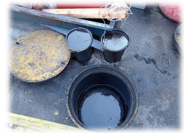
תמונה 7: הוצאת 20 ליטר נוזל לצורך בקרה וכיול
